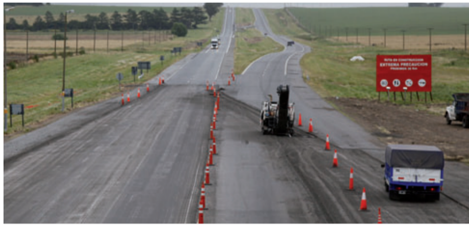
OBRAS DE REPAVIMENTACION SOBRE LA RUTA NACIONAL 226
